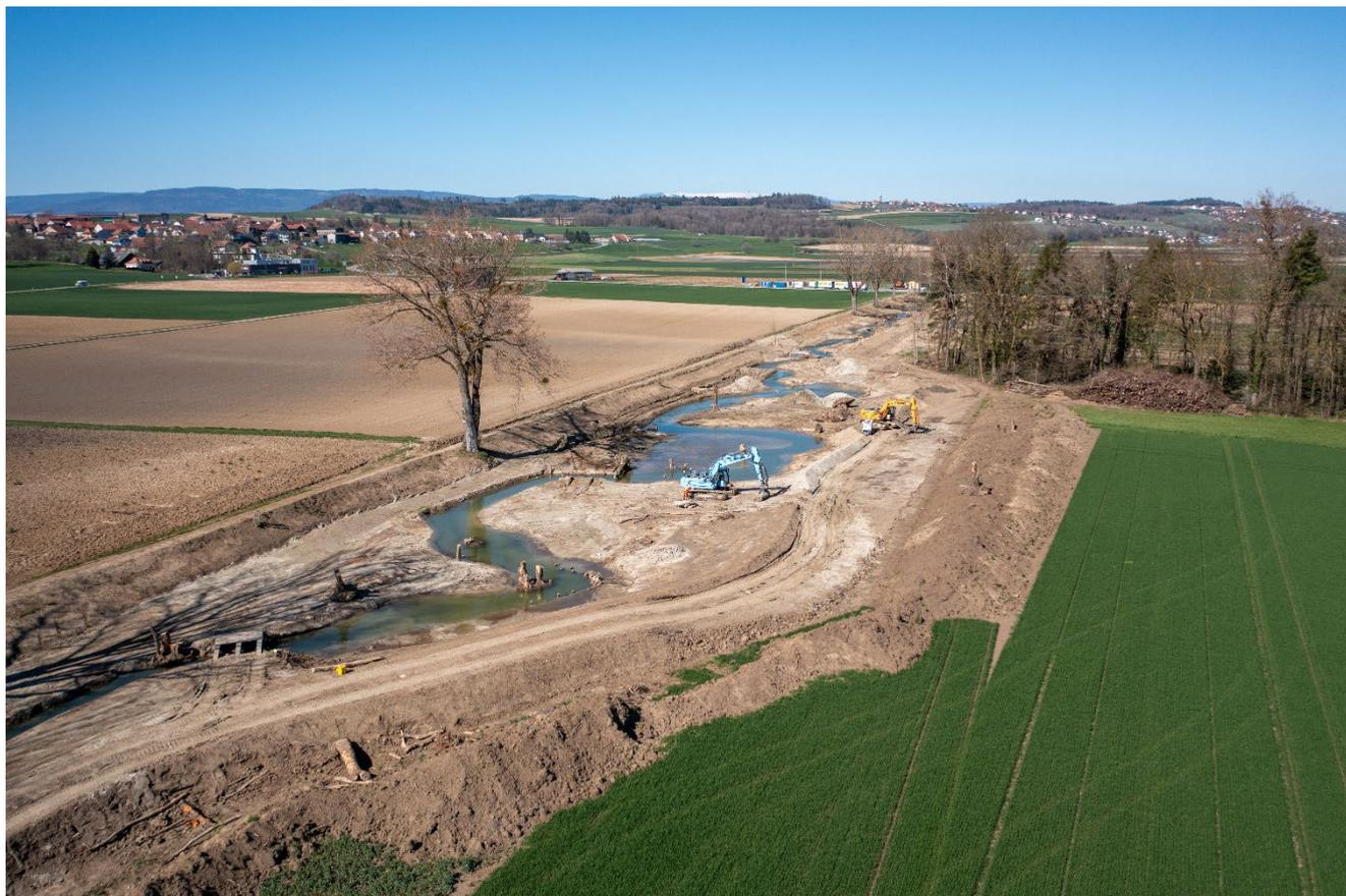
Revitalisierung der Kleinen Glane (erhebliche Aufweitung des Fließgewässers sowie Anböschung des neuen Flussbetts und der Ufer in Saint-Aubin), 4. April 2023. © Upperview Productions
