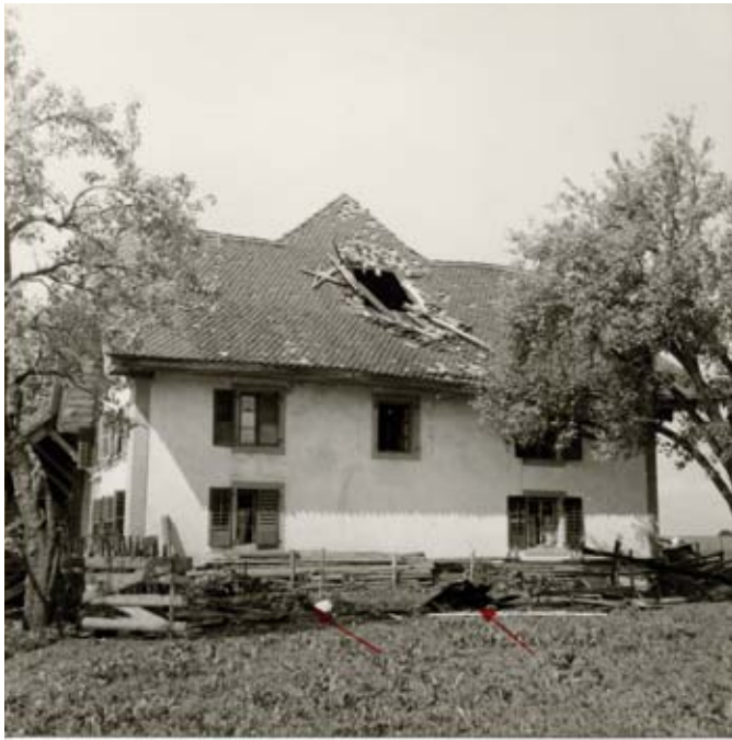
Endroit où la foudre a atteint la ferme, sur la cheminée qui a été pulvérisée. Flèches: débris de poutres et planches projetés provenant du toit et de la cheminée.
