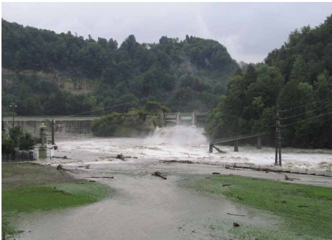
Saanehochwasser bei der Staumauer der Magerau (2005) © AfU
