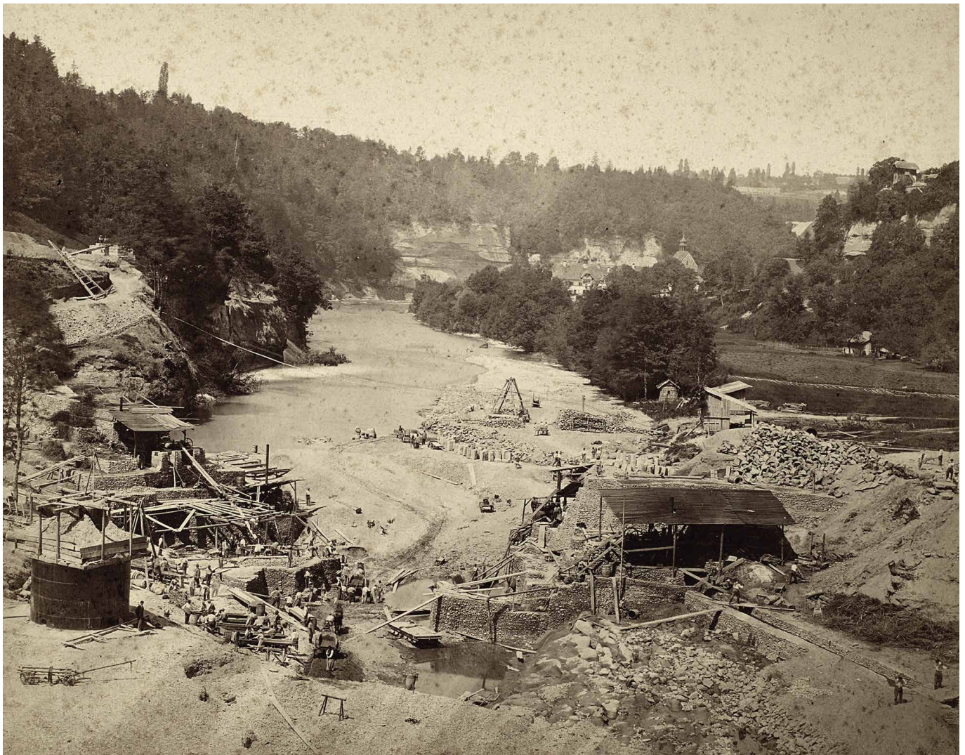
Bau der Staumauer der Magerau (1872). © KUB. Sammlung Fotos auf Karton
