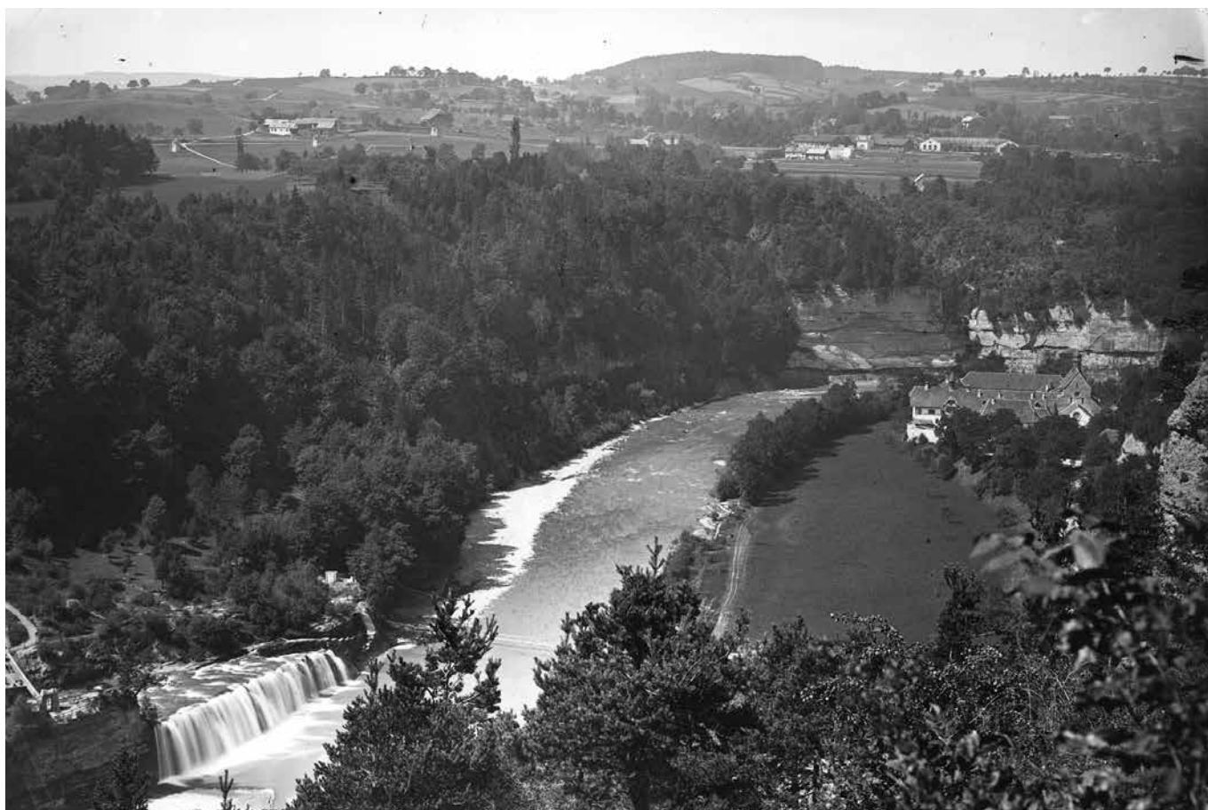
Wasserfall der Staumauer der Magerau mit dem Seiltriebssystem für die Übertragung der Antriebskraft zur Pérolles-Ebene im Hintergrund. © KUB. Sammlung Léon de Weck - Georges de Gottrau
