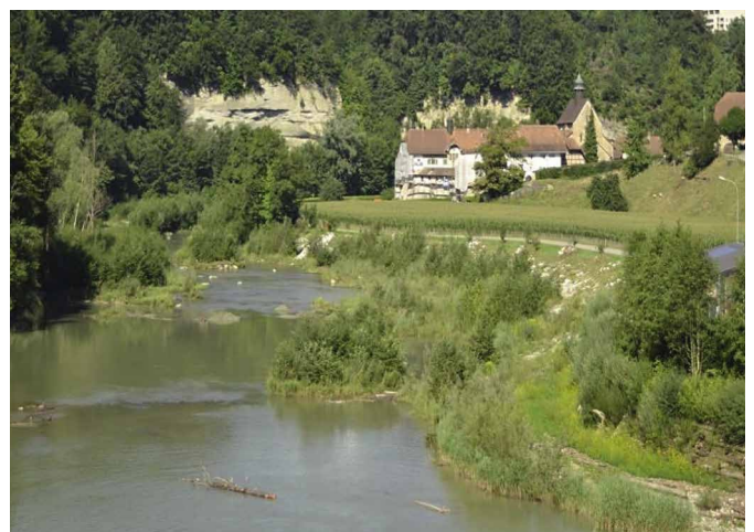
Nach den Arbeiten © AfU
