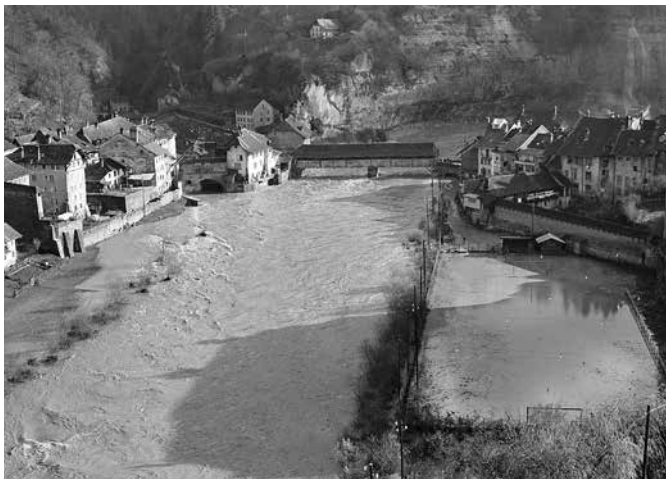
Saanehochwasser von der Zähringerbrücke aus gesehen (1944) © KUB. Sammlung Mülhauser
