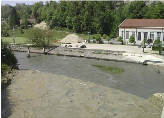
Die Saane bei der Staumauer der Magerau (vor 2005) © AfU
