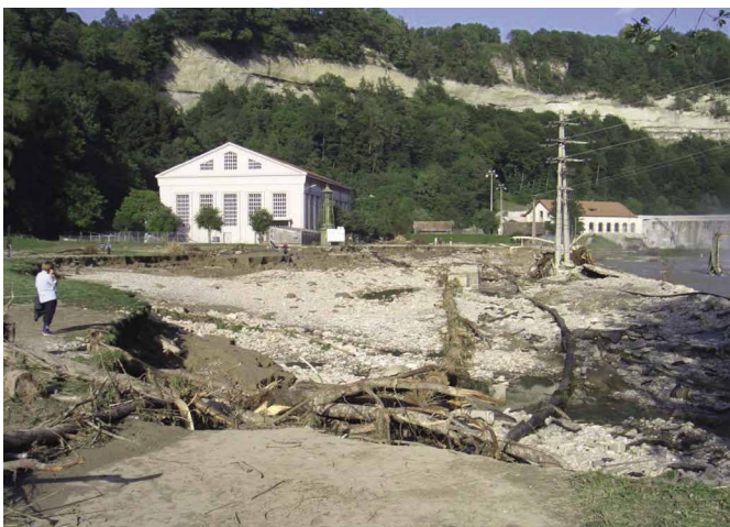
Hochwasserschäden bei der Staumauer der Magerau © AfU
