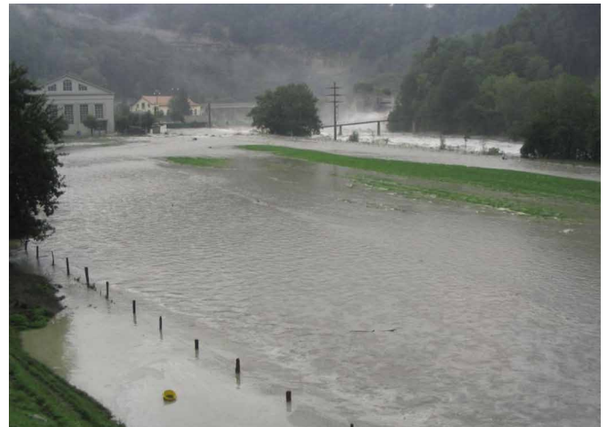
Saanehochwasser bei der Staumauer der Magerau (2005) © AfU
