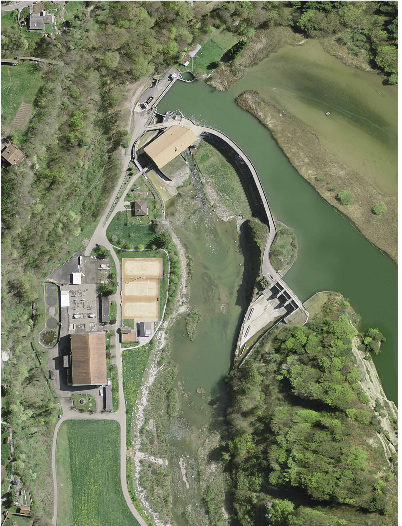
Staumauer der Magerau (Bild B)
