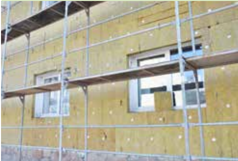
Aussendämmung, Renovierung © iStock
