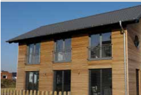
Hinterlüftete Fassade © iStock
