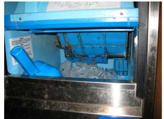
Ungenügende Reinigung einer Eiswürfelmaschine – Rost
