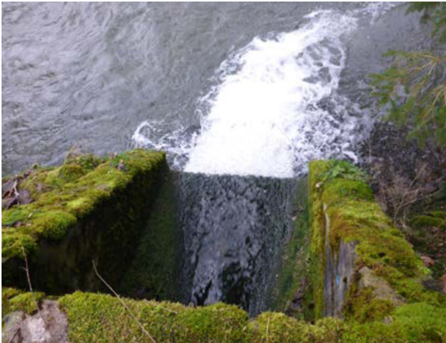
Durchgehende Einleitung z.B. ARA-Ausläufe
