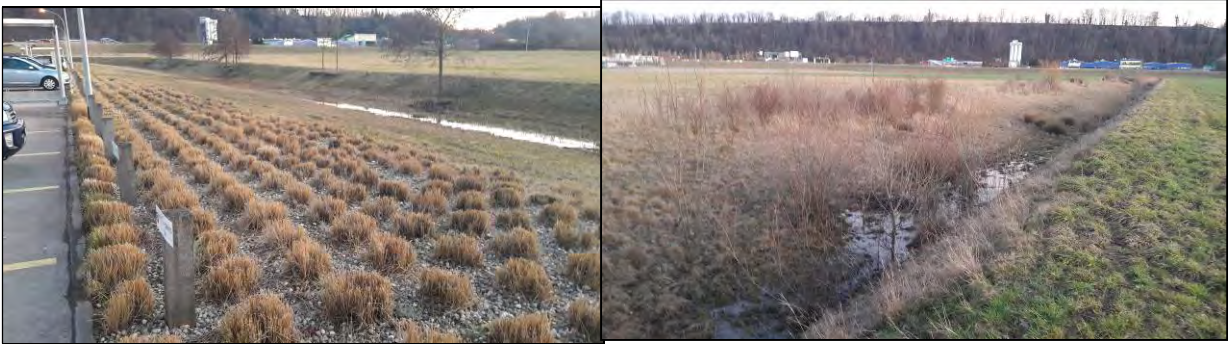
Profil d'une noue principale, avec rétention, largeur env. 7.8 m / Profil d'une noue d'évacuation à l'amont du réseau, largeur env. 7.1 m. La cote « radier crue » est donnée dans le schéma des mesures de protection contre les crues du bureau Triform – rappelé à la page suivante.
