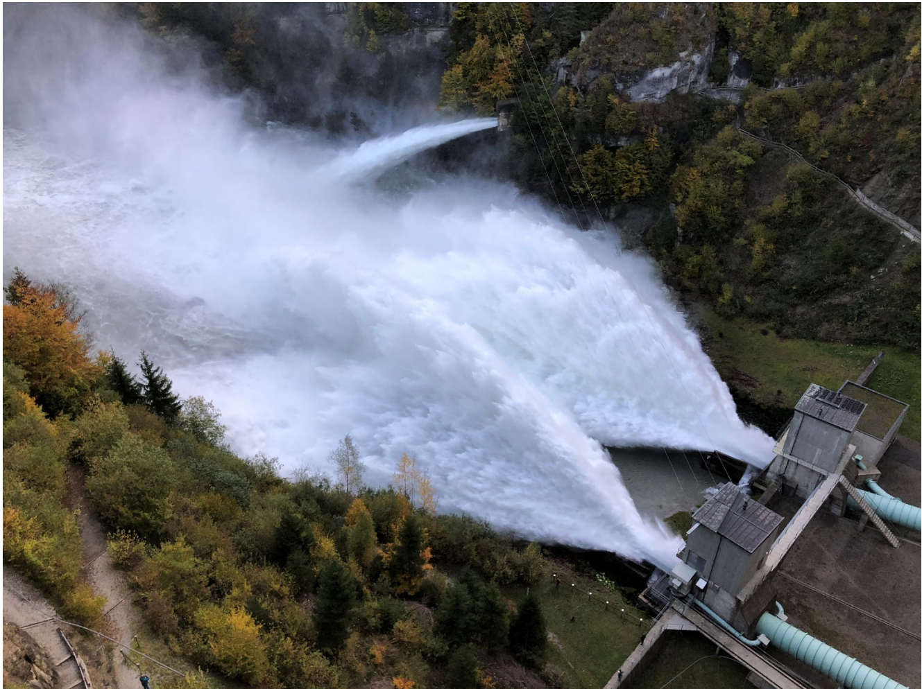
Wasserablass auf der Saane, Staumauer von Rossens, 22. Oktober 2020 (Foto AfU)
