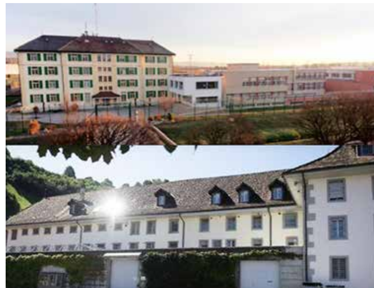
Oben: Panoramaansicht von Bellechasse Unten: Panoramaansicht des Zentralgefängnisses.
