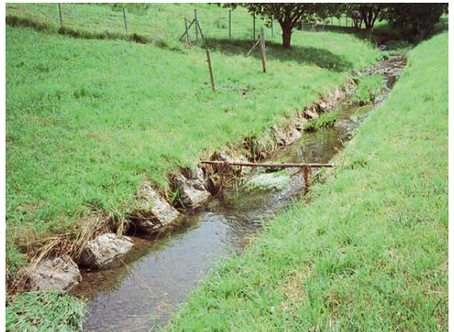
Abbildung 19: Beispiel eines künstlichen Fliessgewässers.
