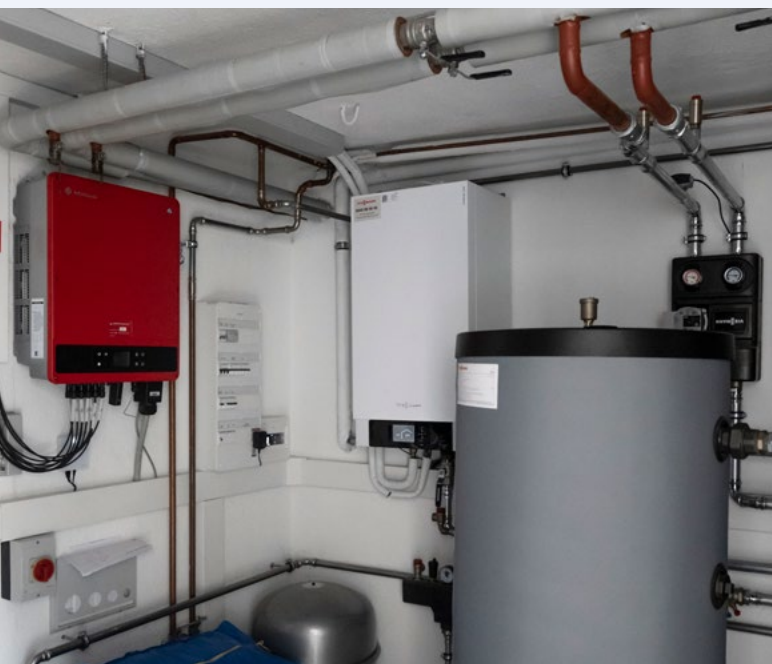
Nach dem Ausbau der Elektroheizung erhielt die Familie mehr Stauraum im Kellerraum.
