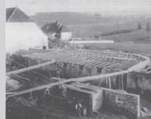
La Grangeneuve avec son toit en demi-croûpe pendant les travaux de la halle
