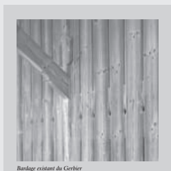
Bardage existant du Gerbier
