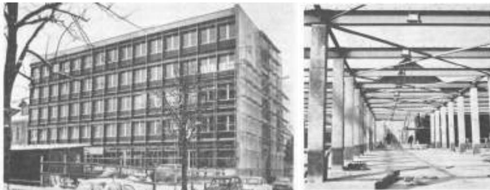
sbz, 90 - n°44 (1<sup>ère</sup> étape de construction, à gauche) – (structure métallique horizontale et piliers en béton préfabriqué au centre du bâtiment, à gauche)
