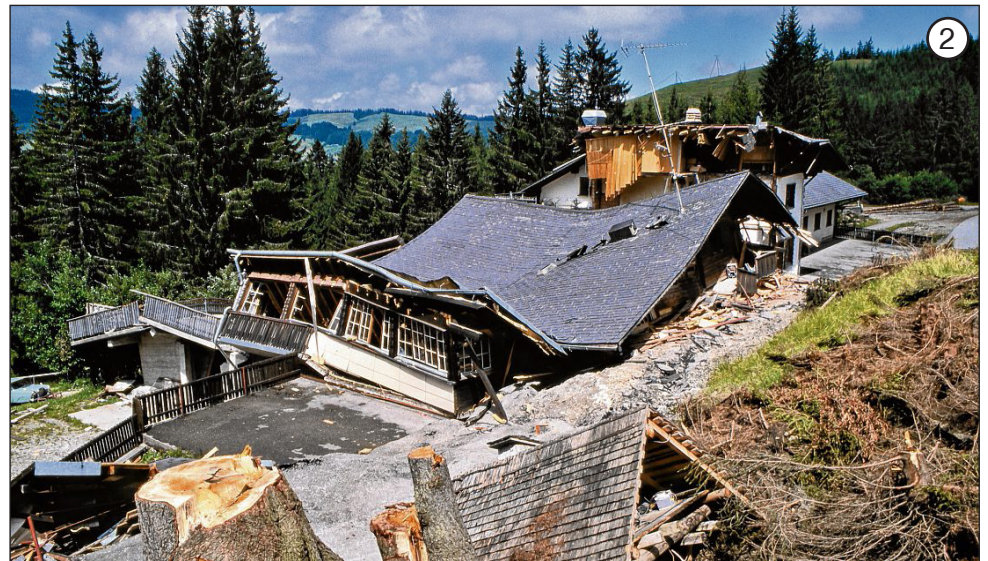
Abb. 3: Katastrophale Reaktivierung der Rutschung Falli-Höllli im Jahr 1994. Bild 1: Der Mittelteil der Rutschung reisst das aus etwa vierzig Häusern bestehende Feriendorf fort. Bild 2: Am 21. Juli 1994 verursachen die Massenbewegungen den Einsturz des Restaurants Falli-Höllli.
