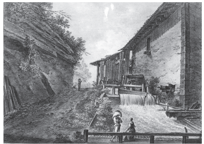
Abb. 6: Links: Unteres Kupferstampfwerk, das im 19. Jahrhundert zur Ölmühle umgenutzt wurde (E. Curty, 1805). Rechts: Eisenstampfwerk unweit der heutigen Fischzucht. Ein Damm im Galterengbachlauf ermöglichte die Umleitung des Wassers in einen Kanal, der eine Vielzahl an Mühlen speiste (Autor und Datum unbekannt).
