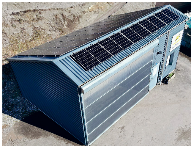
Centre collecteur de Châtillon Sammelstelle von Châtillon
