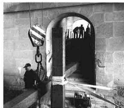
Susanne Breidenbach, Installation de «Maillart Extended» sur le pont de Grandfey, 1988
