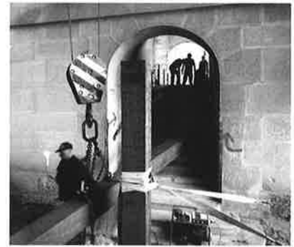
Susanne Breidenbach «Maillart Extended» wird auf der Grandfey-Brücke installiert, 1988
