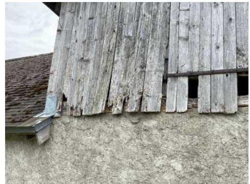
Lames bois pont de grange façade N.O
