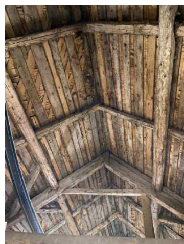
Etat général de la charpente
