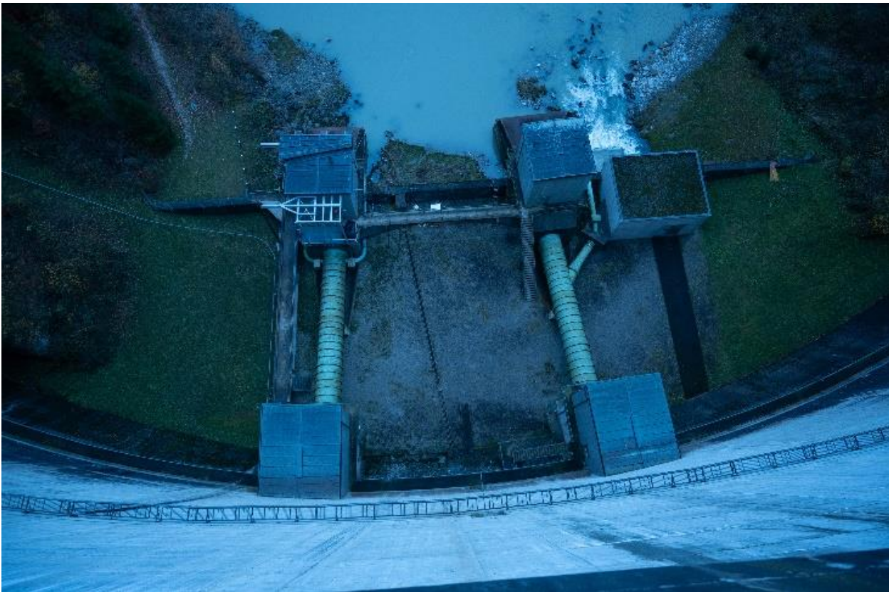
Le barrage de Rossens fournit chaque année de l'énergie à plus de 46'000 ménages. L'énergie renouvelable est une priorité pour le Conseil d'Etat qui a soutenu la Loi fédérale sur l'énergie allant en ce sens.
