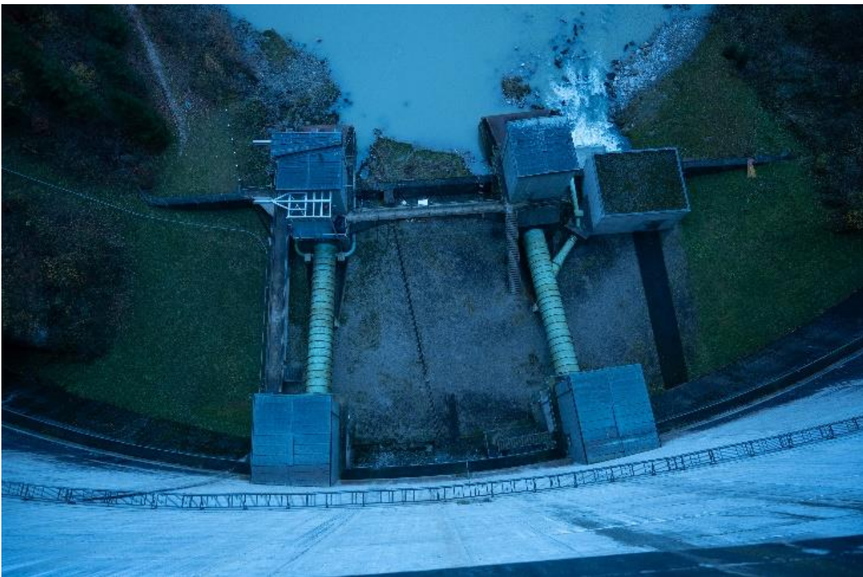
Der Staudamm von Rossens liefert jedes Jahr Energie für mehr als 46 000 Haushalte. Erneuerbare Energie ist eine Priorität für den Staatsrat, der das dahingehende Bundesgesetz über die Energie unterstützt hat.
