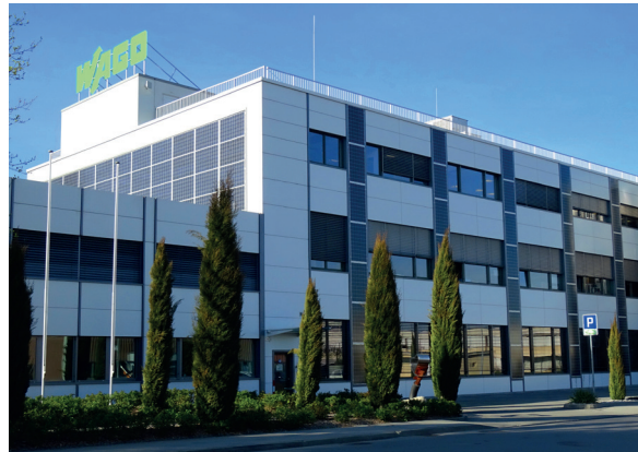
Photo 4.1d: Installation photovoltaïque intégrée aux façades à Domdidier (FR). Source: NET SA
