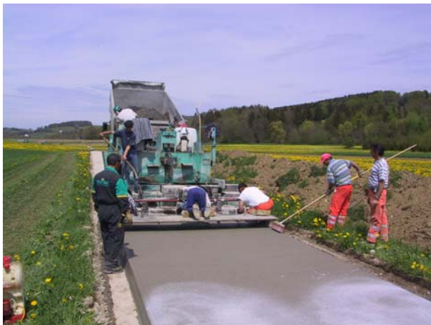
Photo 16: Bau eines Betonweges in Ecublens (LwA).
