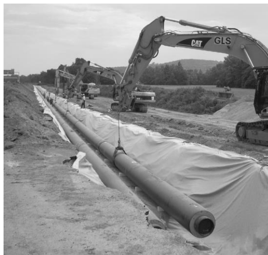
Bild 4.19 Fernwärmerohre werden in den Graben gehoben [51].
