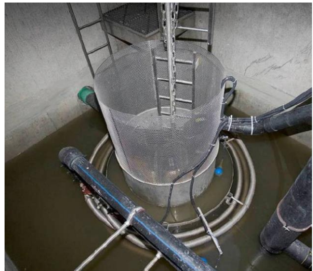
Bild 2.17 Wärmerückgewinnung aus Abwasser in einer Inhouse-Anlage [30].
