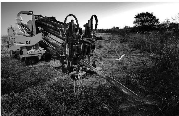
Bild 4.20 Spülbohrmaschine im Einsatz.
