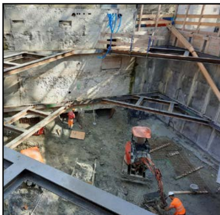
Deux vues du chantier de la nouvelle BCU : la reconstruction des anciens bâtiments a débuté.
