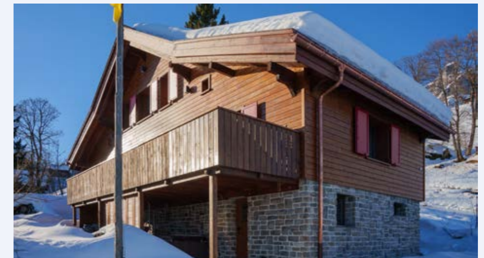
Durch den neuen Anbau ist die Symmetrie des Chalets wieder hergestellt.
