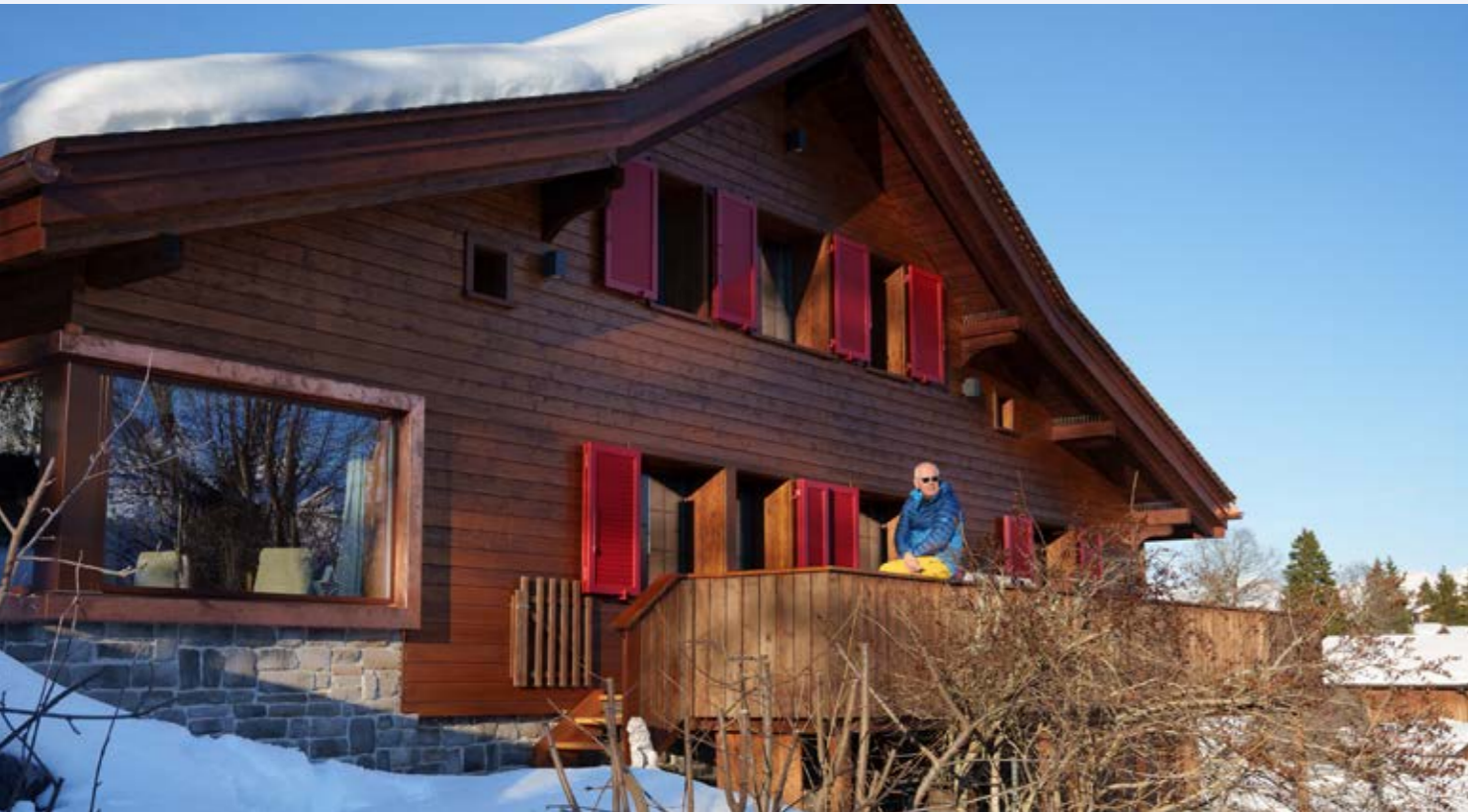
Michael Ladwig vor dem sanierten Chalet
