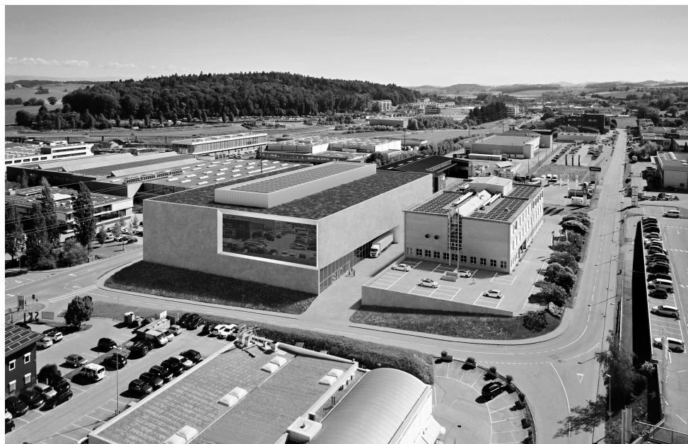
Das Lager für Kulturgüter ist sicherer und kostengünstiger. Es umfasst sechs Lagerebenen, von denen eine unterirdische Etage als Schutzraum für den Kulturgüterschutz dient. © BAT-MANN
