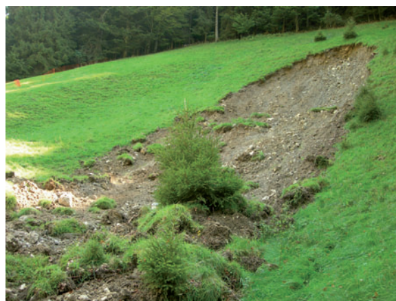
Glissement de terrain spontané (intempéries d'août 2005).
