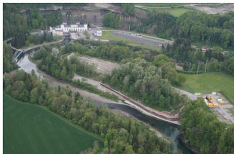
La réalisation des mesures préliminaires à l'assainissement de la décharge s'est terminée en 2014. Le captage des eaux souterraines en amont de la décharge, le confinement partiel de cette dernière avec une paroi de palplanches, ainsi que le pompage et le traitement des eaux permettent de diminuer sensiblement les flux de polluants vers la Sarine.
