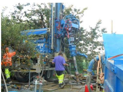
Forage pour sondes géothermiques à 500 m, Düdingen
