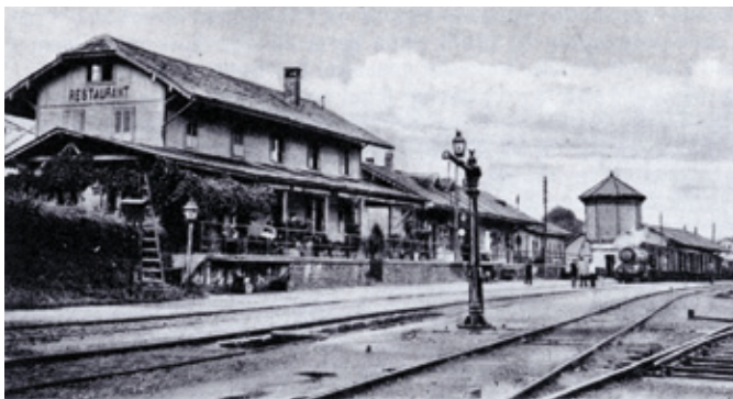
Finalement, c'est Romont qui obtint le passage du chemin de fer en 1862. L'ancienne gare de Romont, en 1902, avec le buffet de la gare, le château d'eau et la halle aux marchandises.
