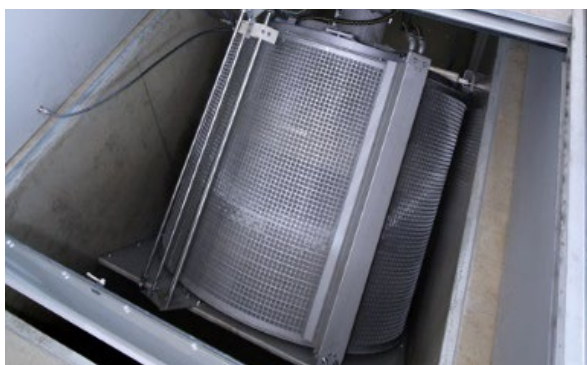
Figure 40 : Tambour de tamisage pour la séparation des matières solides (modèle Huber Picatech).
