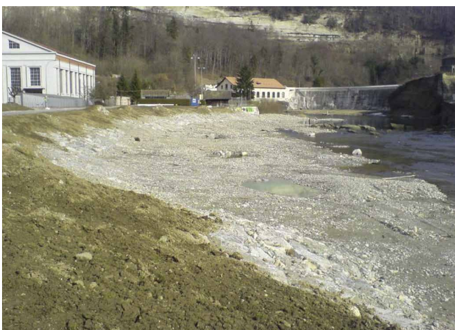
Travaux d'aménagement pour redonner de l'espace à la Sarine suite aux dégâts causés par la crue © SEn
