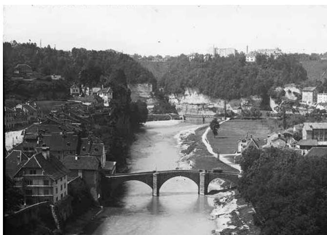
Pont de St-Jean, crue de la Sarine (1890-1900) © BCU. Fonds Albert Cuony
