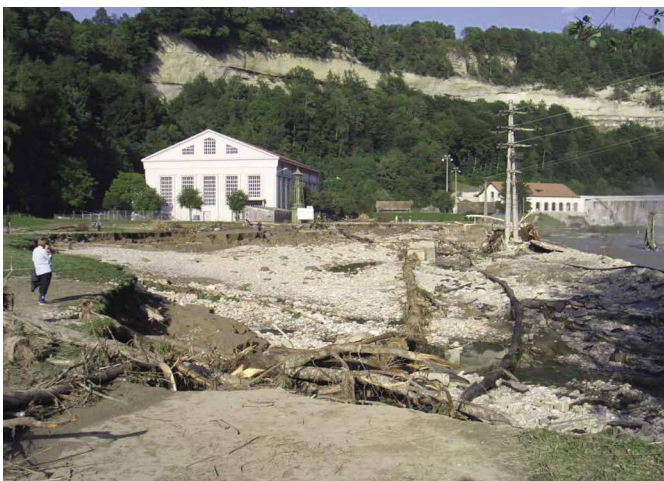
Dégâts causés après la crue au barrage de la Maigrage © SEn
