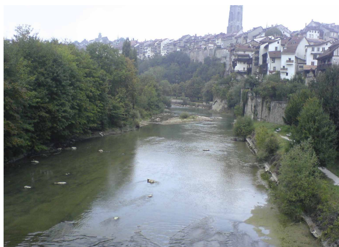
Vue depuis le Pont du Milieu (2009) © SEn.
