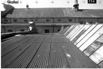
La toiture et une des verrières transversales Bedachung und eine der Querverglasungen
