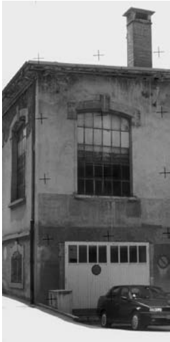
L'angle de la façade latérale et de la façade arrière Ecke zwischen der Seiten- und der Rückfassade
