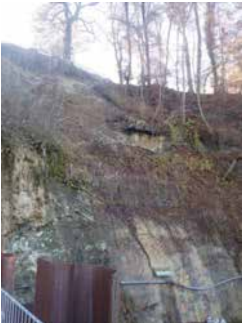
Figure 3-1 Talus hot-spot avec concentrations en PCB de près de 1000 ppm et mini paroi berlinoise au-dessus de la falaise
