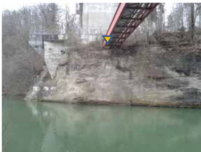
Capteur à impulsions radar (mesure automatique du niveau) Pont Pérolles
