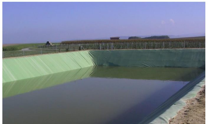
La plupart des grandes cultures sont gourmandes en eau. Il existe plusieurs méthodes pour pallier aux carences temporaires en eau. L'arrosage par aspersion nécessite plus d'eau qu'un arrosage au goutte à goutte. L'irrigation et le pompage au lac représentent des solutions plus durables. Le canton soutient notamment les équipements collectifs d'irrigation et d'adduction d'eau. (© IAG)
