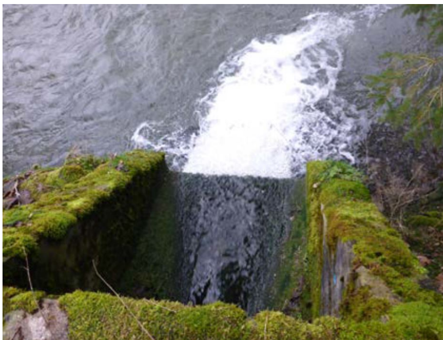
Rejet constant ex: déversoir de STEP
