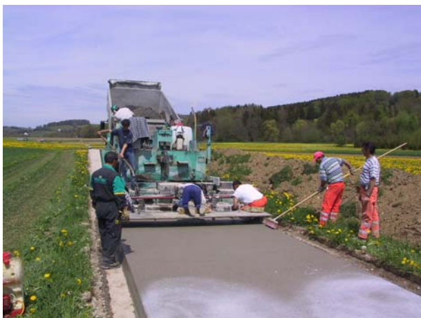
Photo 16: Construction d'un chemin en béton à Ecublens (SAgri).
