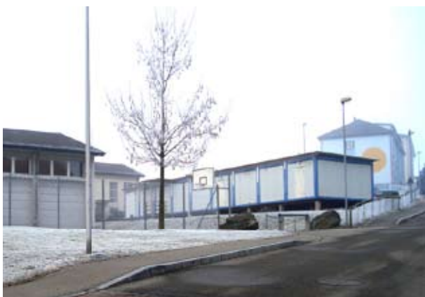
Seit 1994 wird auch in provisorischen Pavillons unterrichtet.
