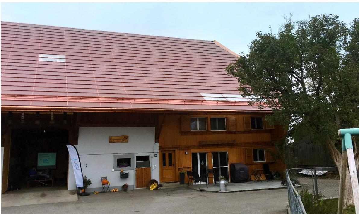
Bauernhof in Ecuwillens, Standort von regionaler Bedeutung innerhalb eines zu schützenden Perimeters der Kategorie 2 im Sinne des kantonalen Richtplans. Pilotprojekt mit der Installation von ziegelroten Solarmodulen auf dem Dach des Bauernhofs in einem denkmalgeschützten Ortsbild. © SBC/KGA
