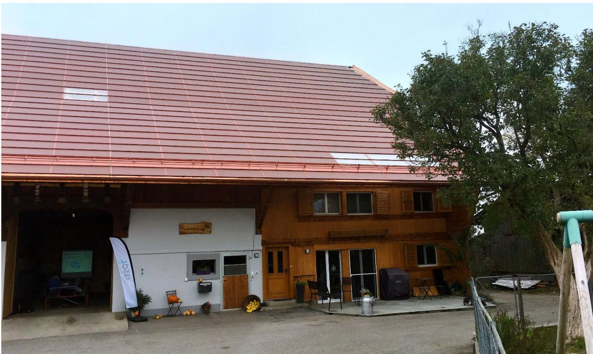
Ferme à Ecuwillens, site d'importance régionale dans un périmètre construit à protéger de catégorie 2 au sens du plan directeur cantonal, projet pilote avec la pose de panneaux solaire de couleur rouge terre cuite sur une toiture de ferme dans un contexte protégé. © SBC/KGA
