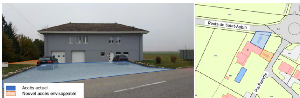
Fig. 35 : Accès actuel et potentiel au bâtiment sis sur l'art 5202 RF (source: urbaplan).
