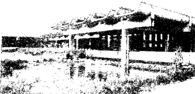
lonerzia, maturazione a vapore, previsione dell'età del conglomerato dei prefabbricati posti in opera, ecc.), le tensioni massime calcolate sono state di 84 kg/cm<sup>2</sup> nel calcestruzzo e di 2.000 kg/cm<sup>2</sup> nell'acciaio di armatura.
