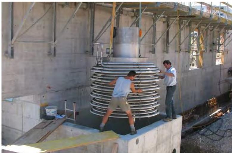
Figure 10 : Mise en place d'un module de récupération de chaleur à l'intérieur d'une fosse de relevage
