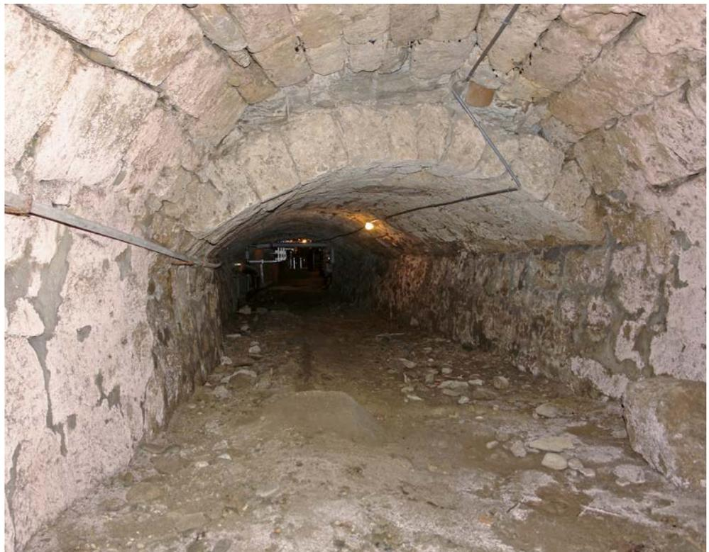
**Fig. 9** Canal souterrain en tuf construit à la période romane
