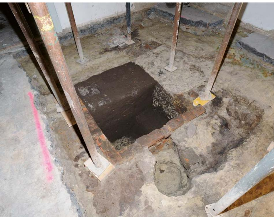
**Fig. 22** Rez-de-chaussée, fosse et rigoles pour les lambourdes du plancher de la boutique/ouvroir, époque moderne
