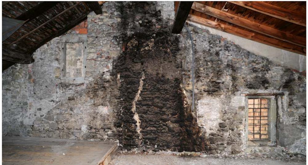
**Fig. 6** Combles, mur mitoyen sud, traces de la borne et fenêtre créée dans le mur pignon du XV<sup>e</sup> siècle ultérieurement murée (tache claire à droite)
