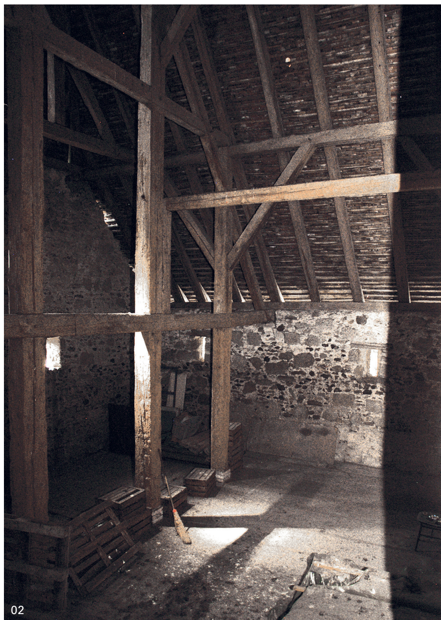
De nombreux volumes sont actuellement inexploités, notamment ceux situés sous l'imposante toiture d'anciennes granges. En cas de reconversion, l'enjeu consiste à développer un programme adapté au bâtiment. Grange du XVII e siècle située à Domdidier (FR).
