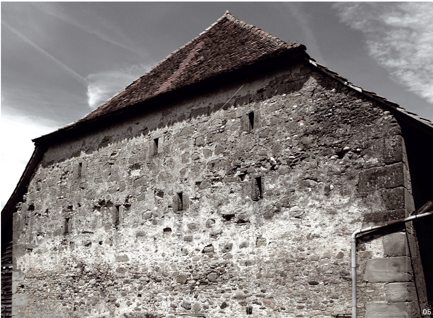
La façade sud-ouest massive en maçonnerie de pierre de la grange avec des fentes d'aération comme seules ouvertures.
