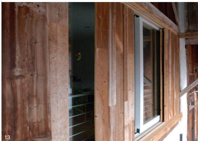
13 Transformation de la grange d'une ferme à Grandvillard (FR), 2002. Christian Dupraz et Pierre-Alain Dupraz architectes, Genève.
