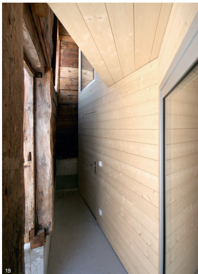
Transformation d'un fenil de montagne à Gluringen (VS), 2011. Benjamin Krampulz architecte sia, Vevey.
