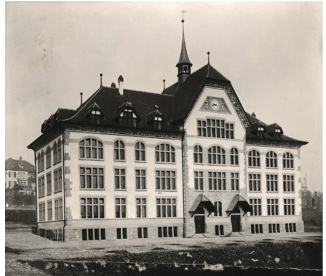
Abb. 1: Gebäude, das 1904–1905 gemäss den Plänen von Léon Hertling (1867–1848), welche die Preisträgerprojekte des Architekturwettbewerbs von 1903 als Grundlage hatten, namentlich das Projekt des Freiburger Architekten Henri Meyer (1856–1930), gebaut wurde.
