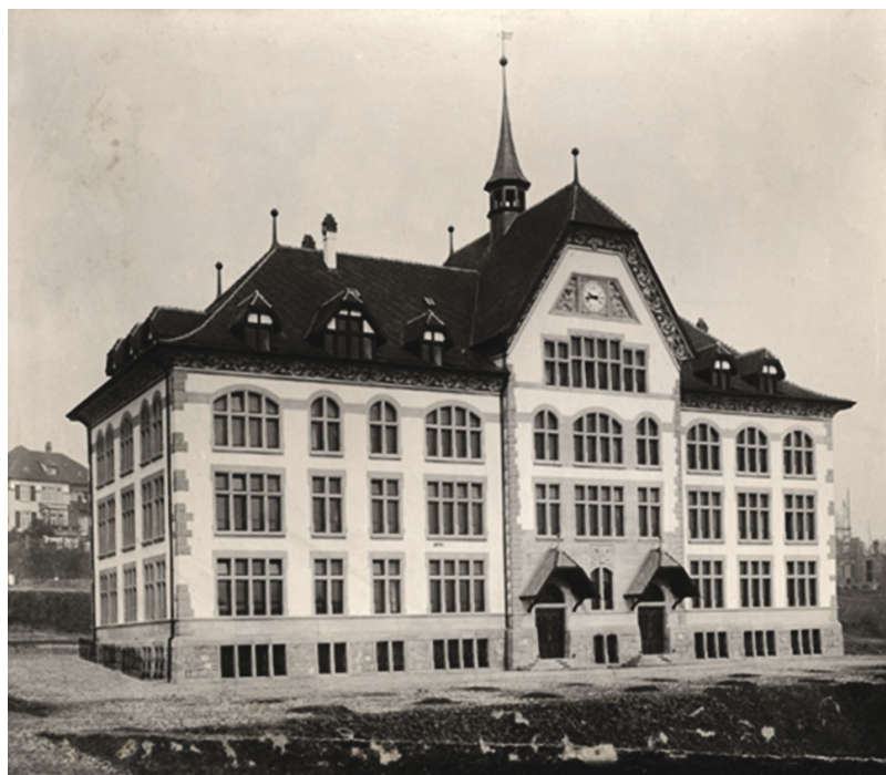
Fig. 1: Bâtiment construit en 1904-1905 sur les plans de Léon Hertling (1867-1848) élaborés à partir des projets primés par le concours de 1903, en particulier le projet lauréat de l'architecte d'origine fribourgeoise Henri Meyer (1856-1930)
