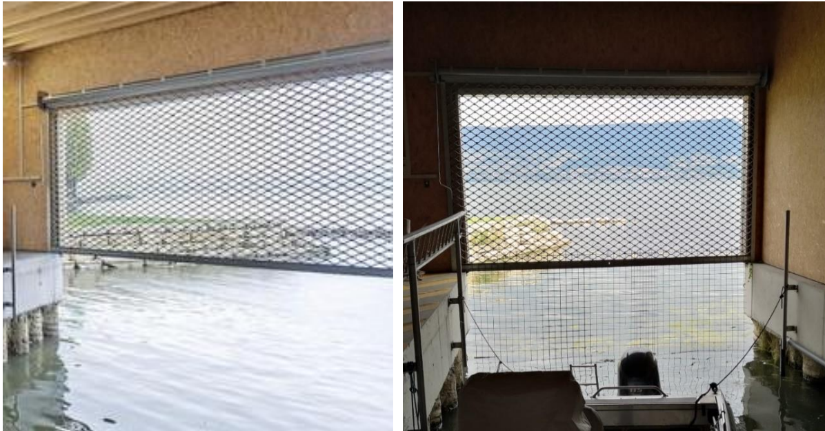
Figure 25 Hangar à bateaux avant et après le rajout de la grille
