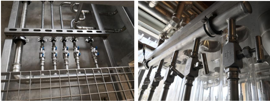
Figure 11 Vannes de réglage principales et vannes de précision des incubateurs
