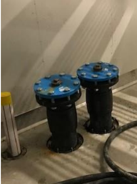
Figure 27 Les deux entrées d'eau du lac brute
