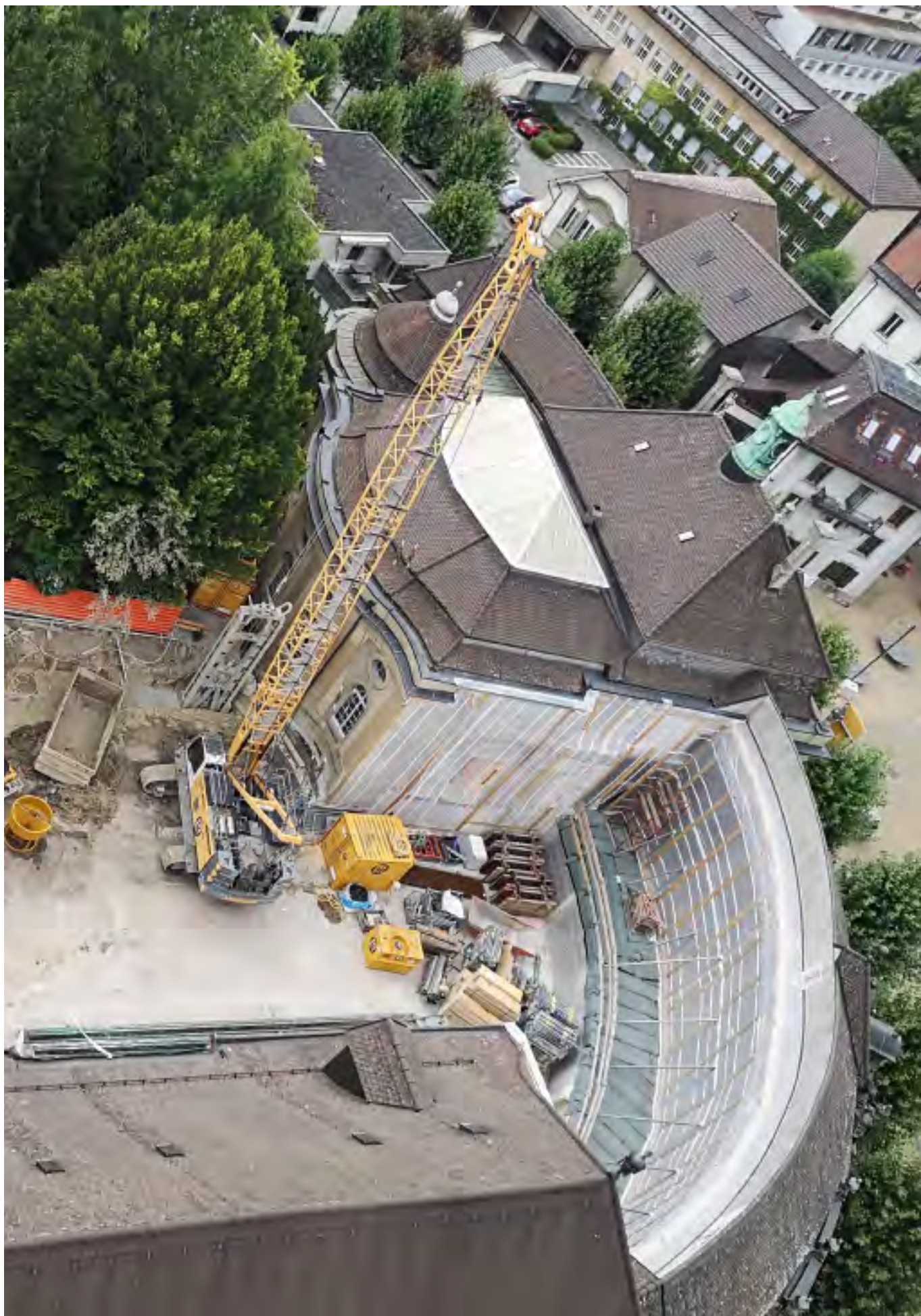
Transformation de la Bibliothèque cantonale et universitaire, en cours de réalisation durant l'été 2021
