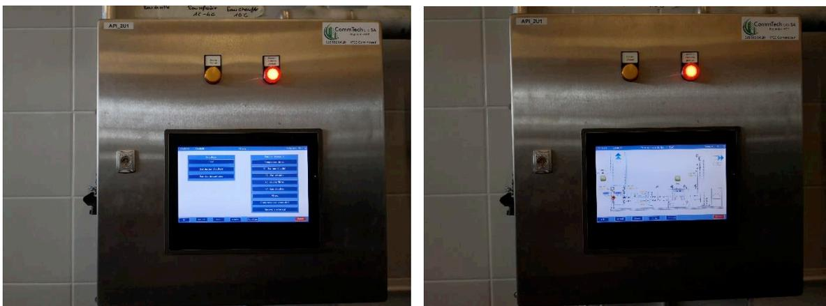
Figure 8 Panneau de contrôle du système d'alarme
