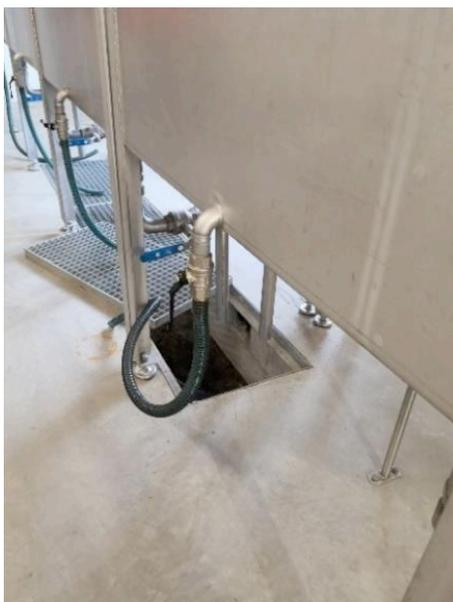
Figure 22 Unique canal d'évacuation d'eau de la salle d'incubation/éclosion
