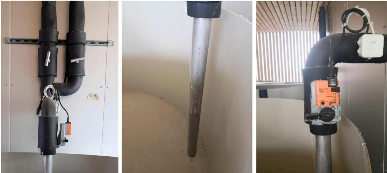
Figure 21 Arrivées d'eau du lac ou du réseau, tuyau d'entrée d'eau du bassin et vanne de régulation du débit
