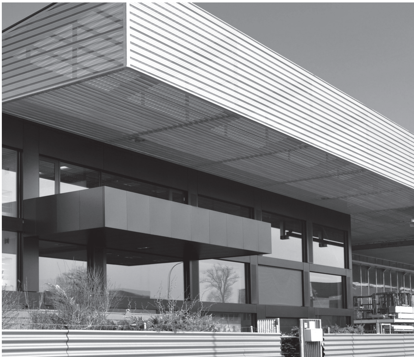
La dernière extension des bureaux de Sottas SA avec échangeurs de chaleur intégrés aux vitrages. Der aktuelle Ausbau der Büros von Sottas SA mit integriertem Wärmetauscher in der Verglasung.
