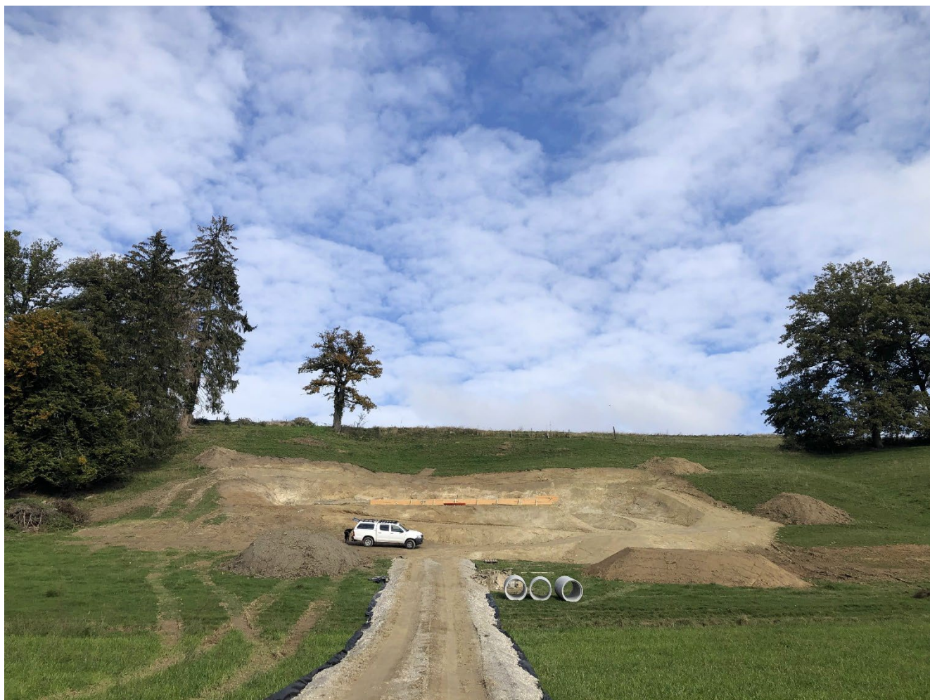
Butte de tir de Prez-vers-Noréaz pendant l'assainissement en 2021
