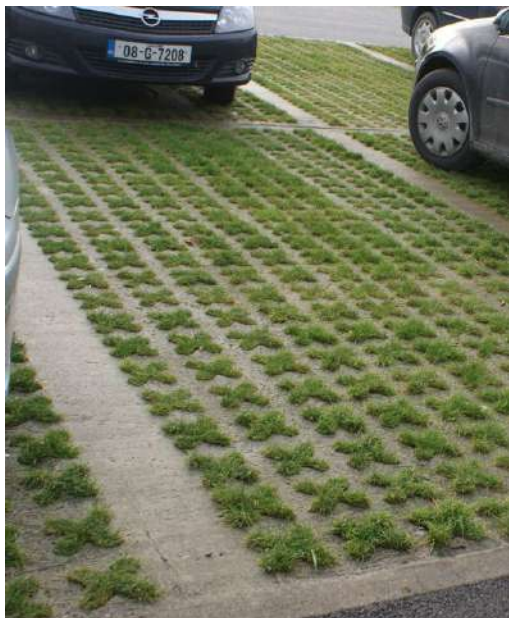
Référence : Parking, Portland Ce parking à Portland (Oregon) est réalisé à partir de dalles alvéolées végétalisées pour les espaces de stationnement et de pavage drainant pour les espaces de circulation.
